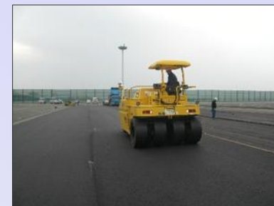
転圧 (タイヤローラー)
