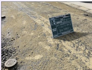
養生砂敷き均し完了
