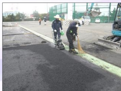
合材転圧（端部）プレート
