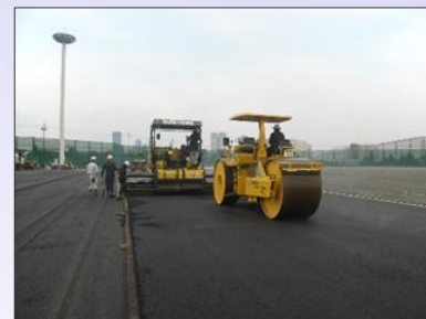
転圧 (マカダムローラー)
