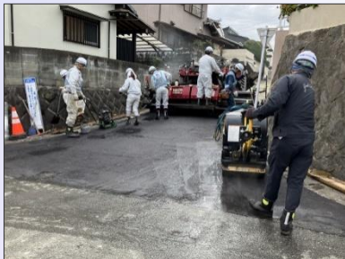
合材転圧 (端部) 振動ローラー
