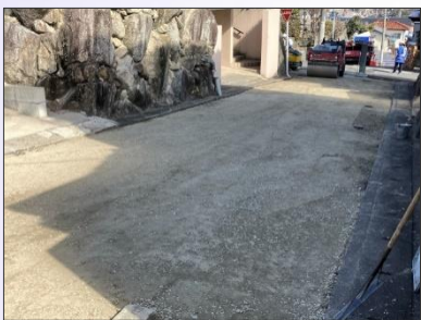
補足材敷き均し完了
