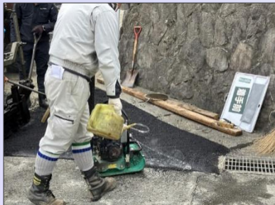
合材転圧 (端部) プレート
