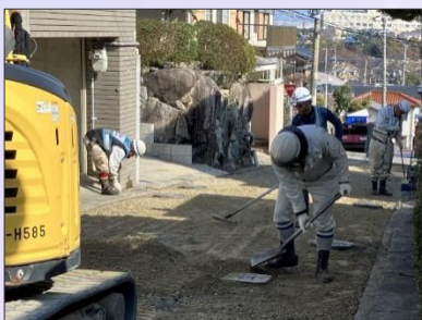
補足材敷き均し (人力)
