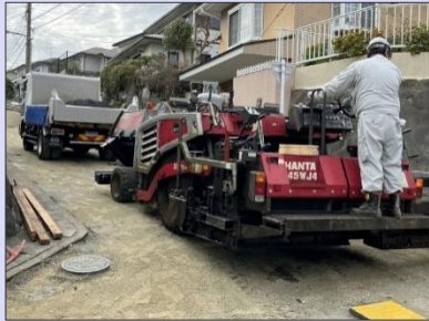
アスファルトフィニッシャー設置
