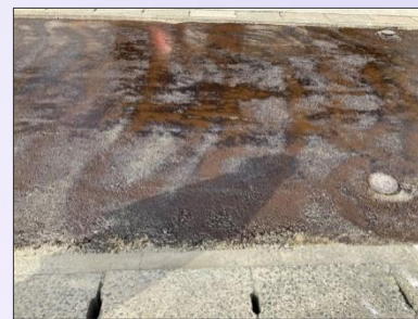
乳剤散布完了
