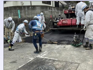
合材敷き均し (端部)
