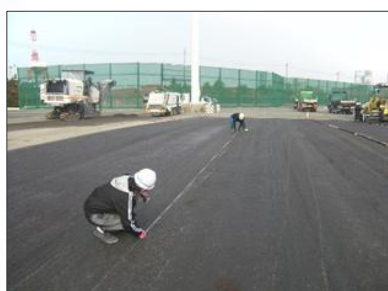
舗装型枠（方線）
