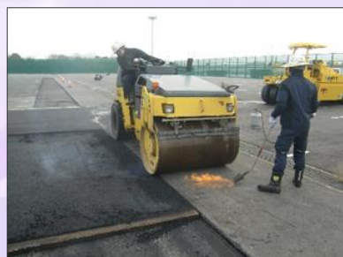
合材転圧（端部）コンバインドローラー
