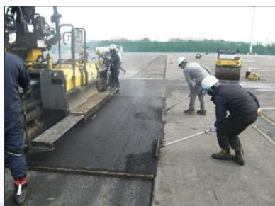
合材敷均し（端部）
