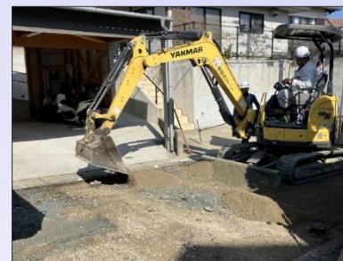
補足材敷き均し (バックホ)
