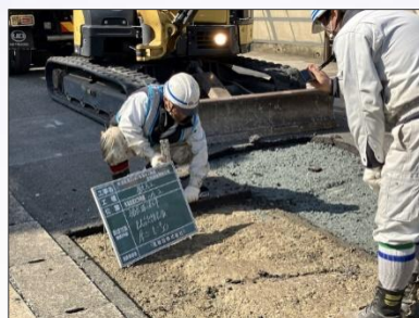
舗装版厚測定
