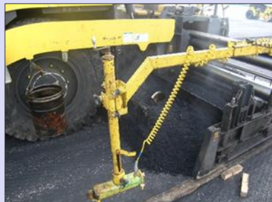
敷均し厚測定 (センサー)
