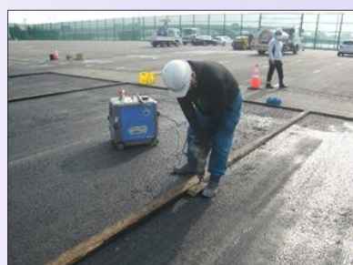
舗装型枠（固定）
