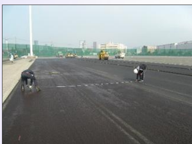
舗装型枠（位置だし）
