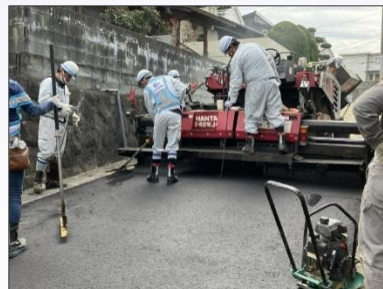
敷均し厚確認 (プレート)
