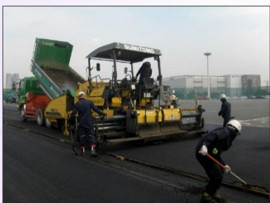
合材敷均し（アスファルトフィニッシャー）
