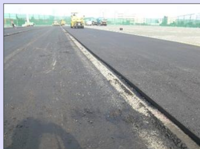
舗装型枠撤去
