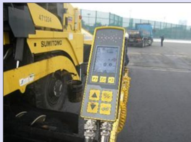
敷均し厚測定 (センサー)
