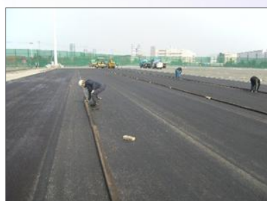
舗装型枠（設置）
