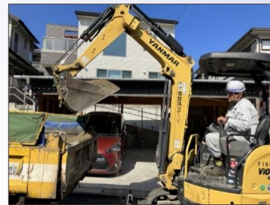
補足材敷き均し (バックホ)
