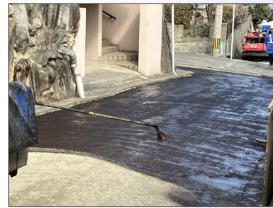
乳剤散布 (スプレーヤー)
