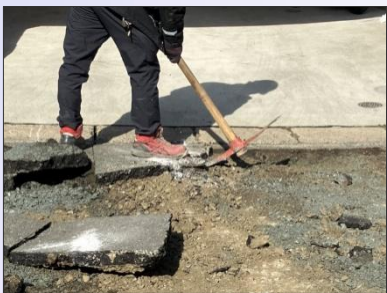
舗装版破碎 (人力)
