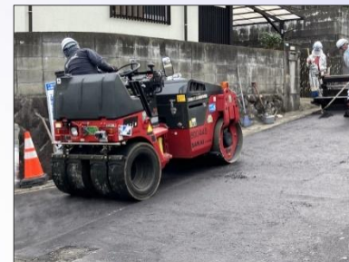
合材転圧 (タイヤローラー)
