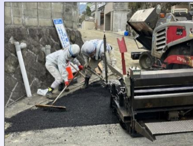
合材敷き均し (アスファルトフィニッシャー)
