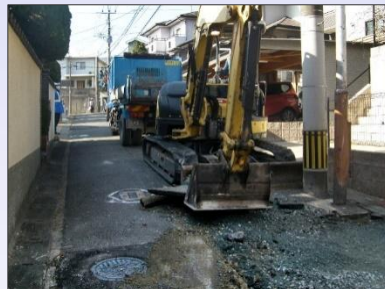
舗装版破碎 (バックホ)
