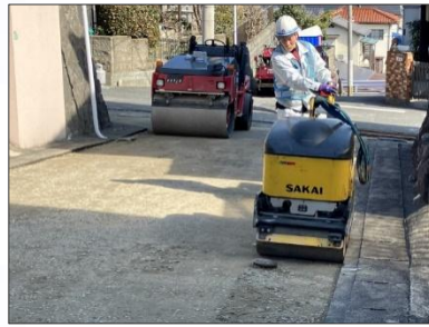
補足材転圧 (振動ローラー)
