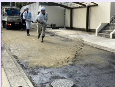
養生砂敷き均し
