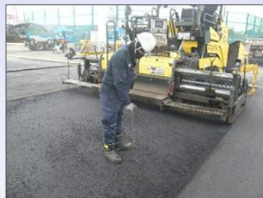
敷均し厚確認 (ハ°レーター)
